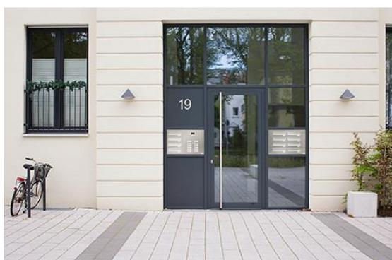
Bild 2 Türseitenteil Briefkastenanlage mit Modulstanzung
